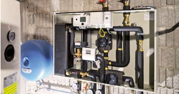
Übergabestation während Installationsarbeiten bei Wärmebezüger/Kunde
