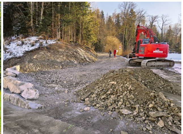
Ausbau Erschliessung Enetriederwald (Fotos: Wendi Kiser)
