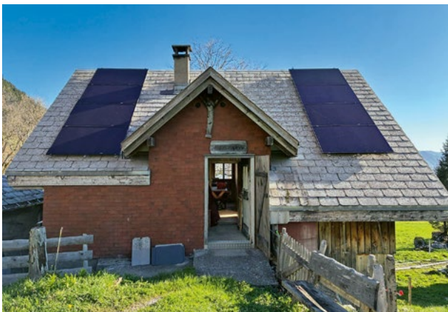
Neue Solaranlage Alphütte Spis
