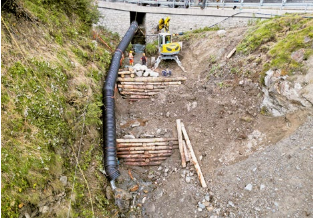
Bachverbauung St. Moritz (Foto: Arnold Denot)
