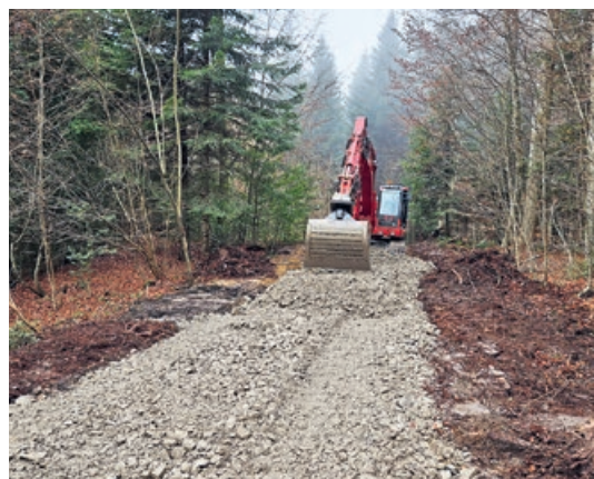
Ausbau Erschliessung Enetriederwald
