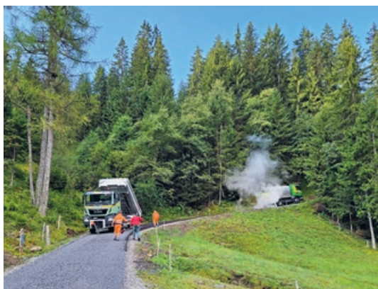
Oberflächenbehandlung auf der Strasse Witenmattboden-Teufibach
